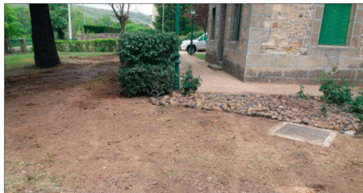
Fotografía de las obras concluidas facilitada por Diputación. DIPUTACIÓN
