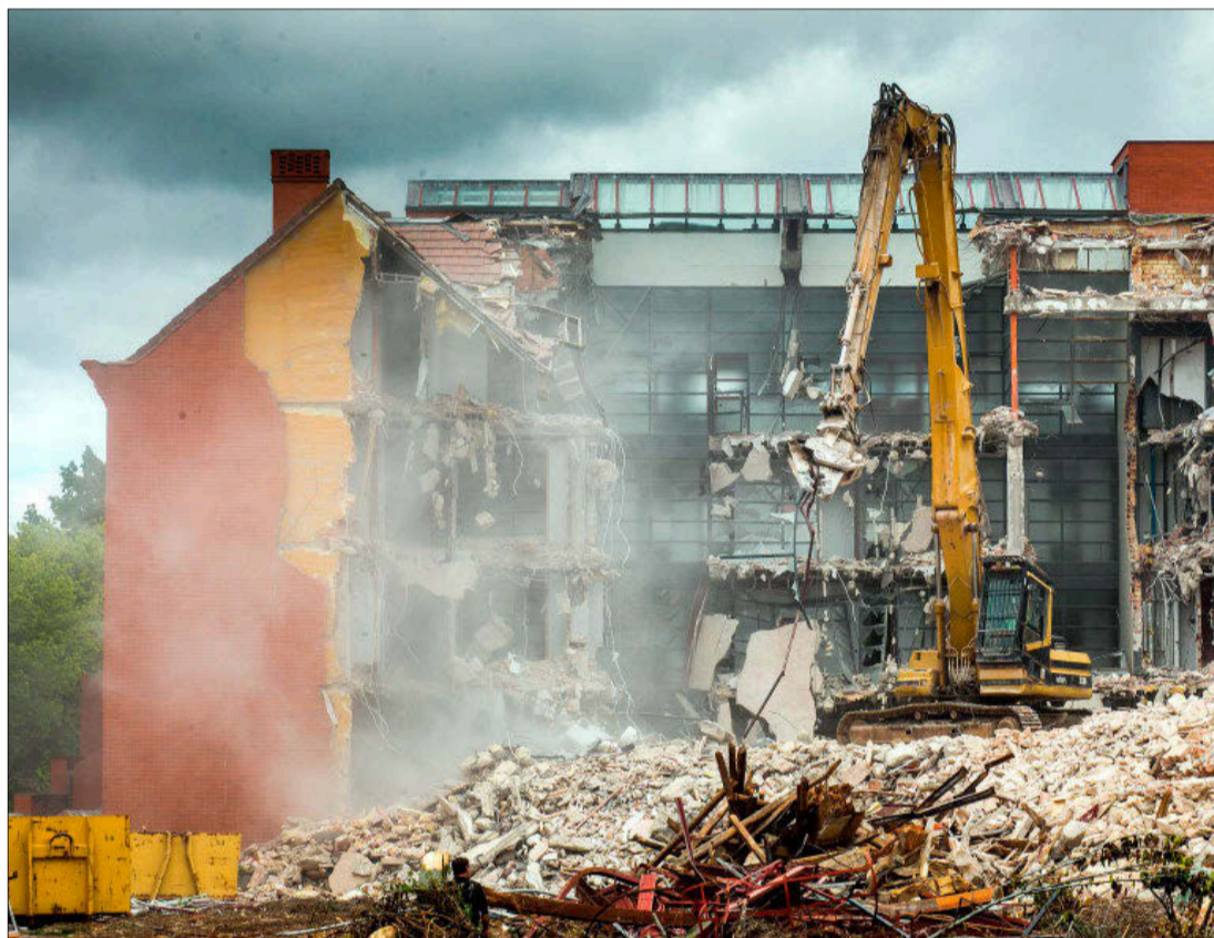
El derribo del edificio ubicado junto al seminario de San José avanza a buen ritmo. TOMÁS ALONSO
